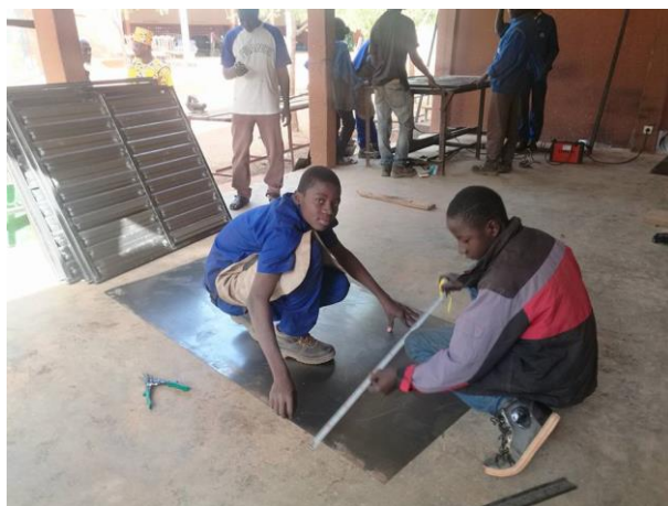
Formation Construction métallique
